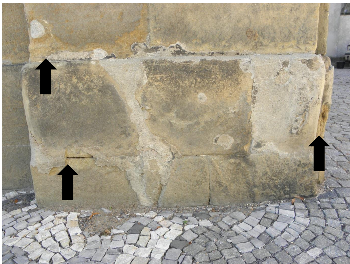
Obr. 30/ Sokl průčelí, nároží vpravo – detail. Znečištěný, rozsáhlé cementové výplně, pod nimiž kámen degraduje a eroduje.
