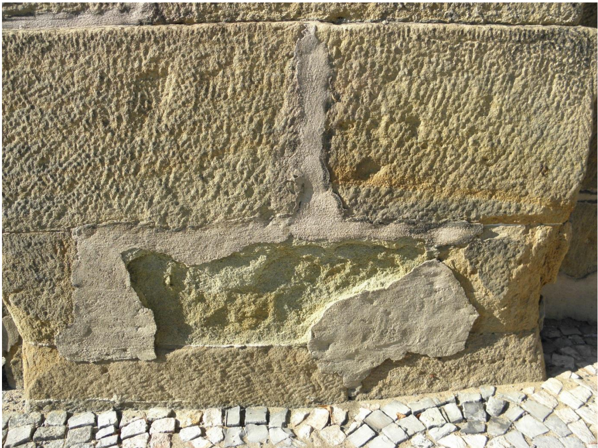
Obr. 31/ Sokl průčelí, nároží vlevo – detail. Výrazná eroze způsobená zasolením a cementovými výplněmi
