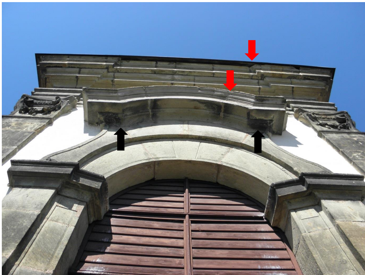
Obr. 1/ Průčelí věže. Korunní římsa, suprafenestra - patrné ztráty subtilních částí ■, krusty ■
