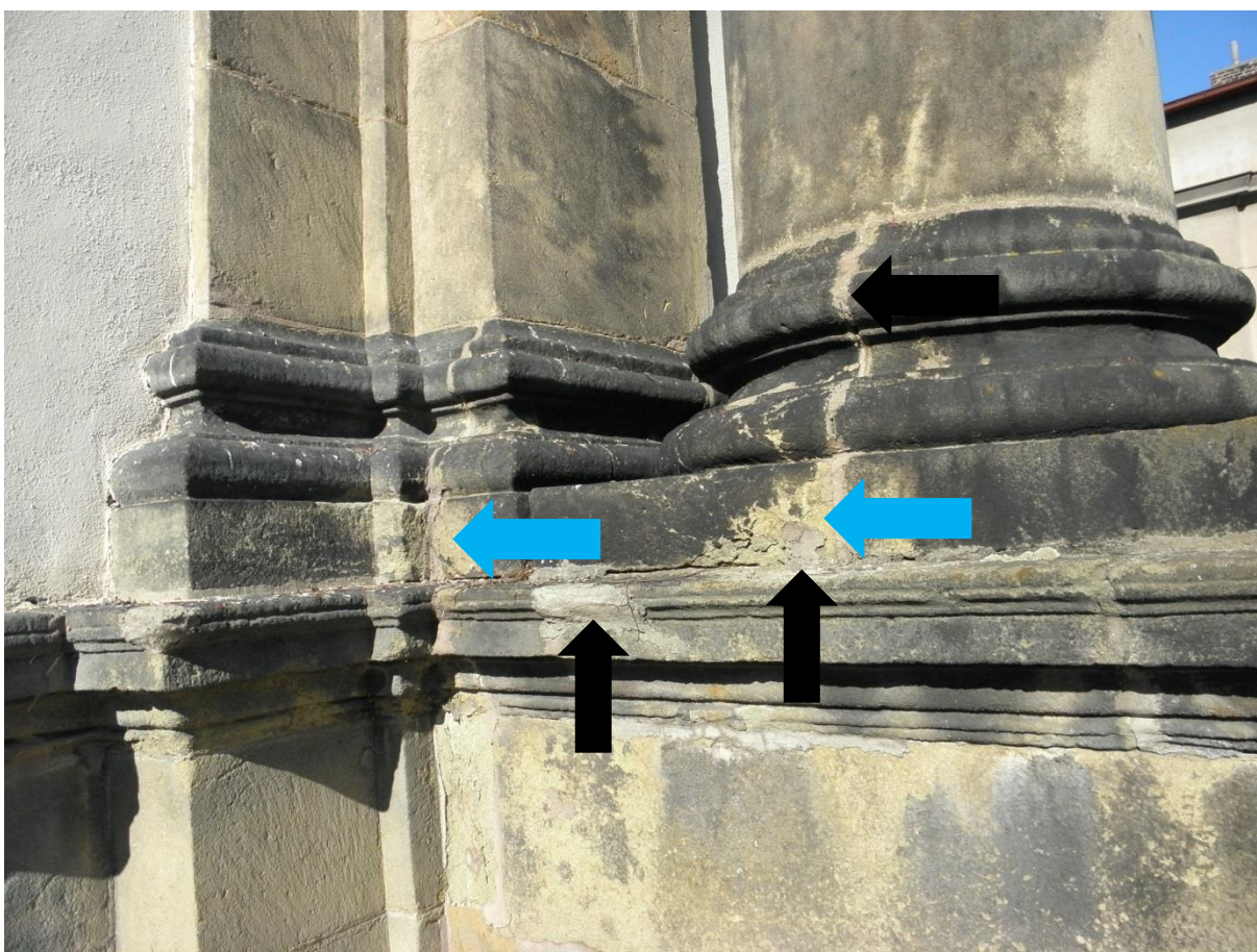
Obr. 20/ Oblast patek sloupu a pilastru vlevo. Tmavé depozity, holubí trus, eroze ■, vadné vysprávky ■
