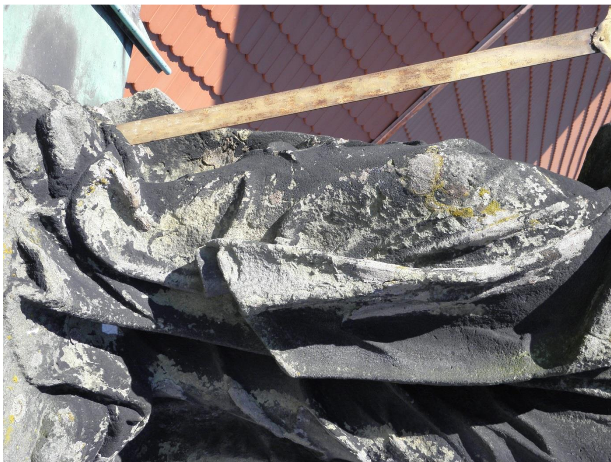
Obr. 35/ Pravá noha sv. Petra. Povrch degradovaný vlivem výplně.
