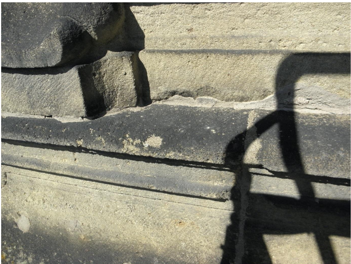
Obr. 8/ Podstavec erbu. Výrazné znečištění tmavými depozity.
