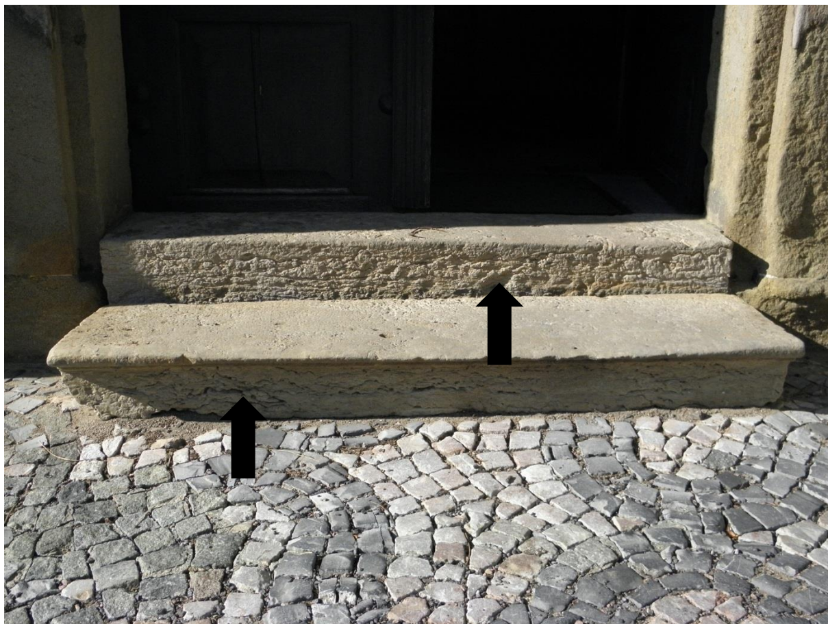
Obr. 29/ Opukové stupně ve vstupu vedlejšího vchodu vlevo. Hornina je hloubkově erodována
