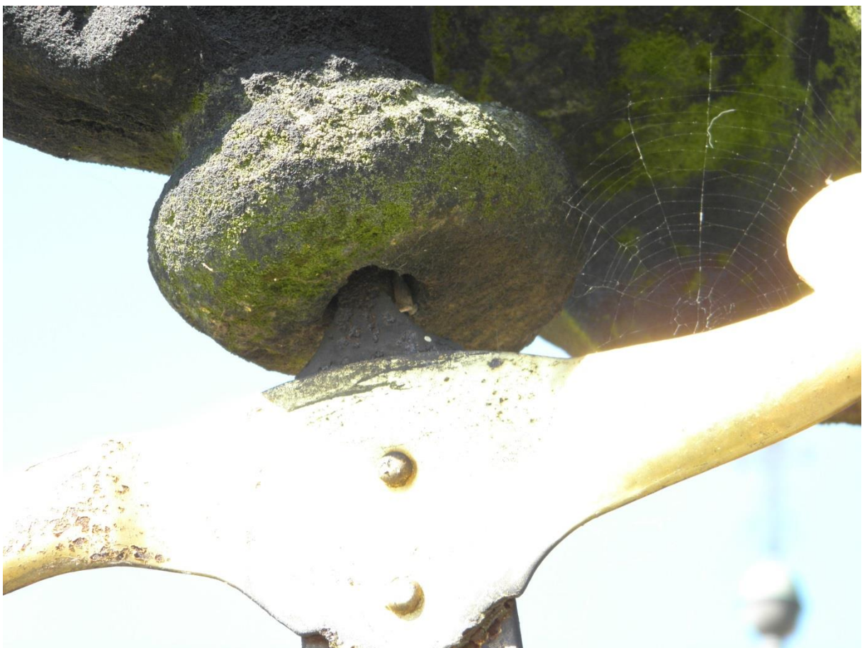
Obr. 40/ Meč sv. Pavla – detail. Korodující zlacená ocel, místo uchycení do kamenné rukojeti.
