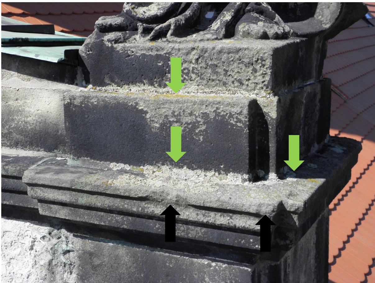
Obr. 33/ Horní část podstavce s plintem sochy sv. Pavla. Tmavý povlak s erozí, ztráty subtilních částí ■, biologické napadení povrchu ■
