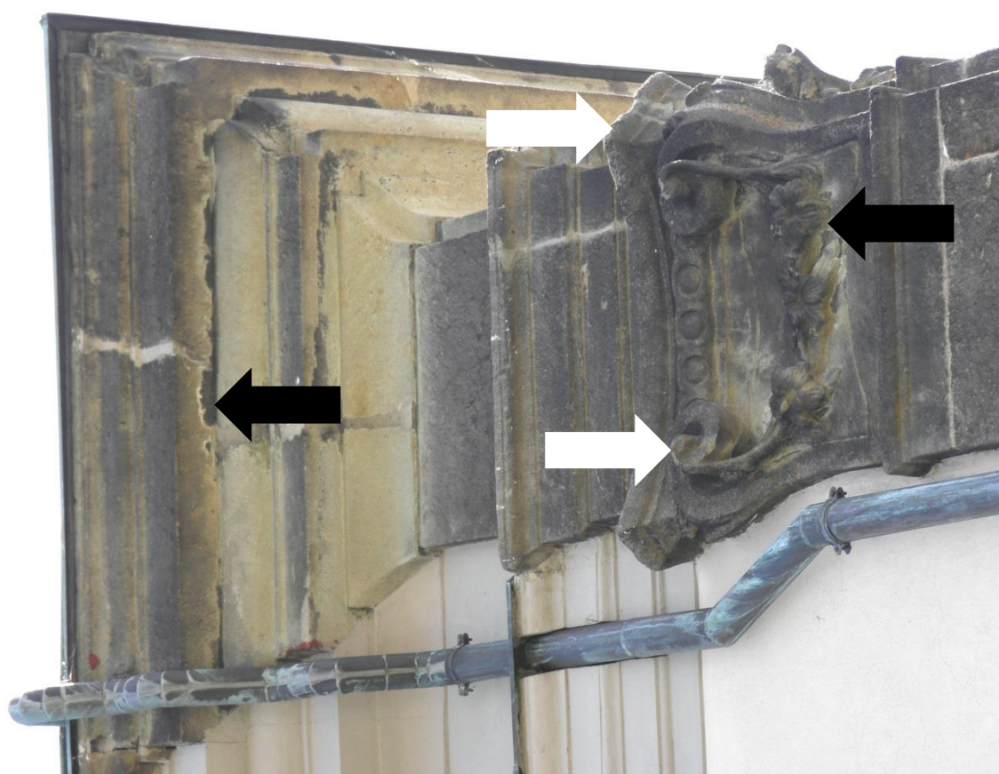
Obr. 9/ Hlavice pilastru věže vlevo (strana sv. Petra). Výrazné znečištění, krusta ■, eroze □
