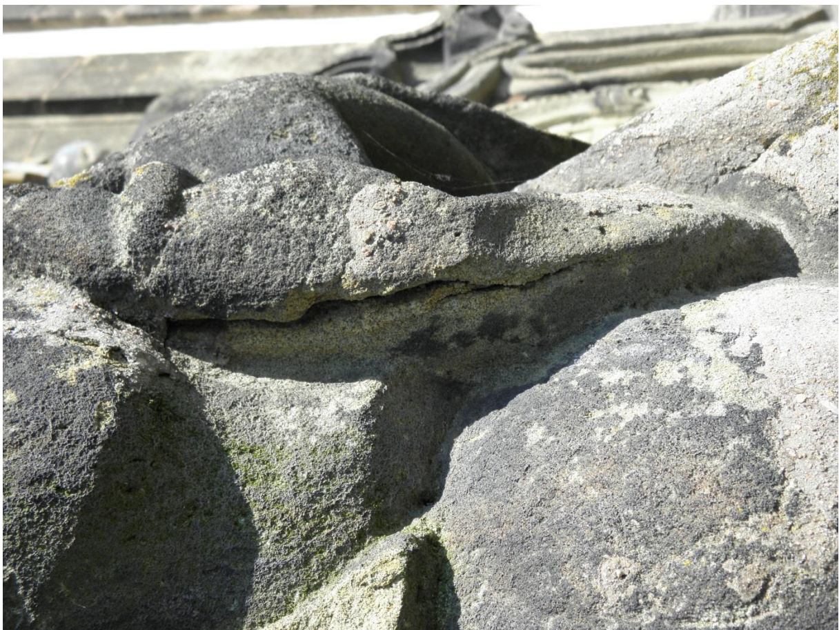
Obr. 37/ Plášť v oblasti pravé nohy sv. Pavla – detail. Hlubková koroze kamene. Uvolněné vysprávkky.
