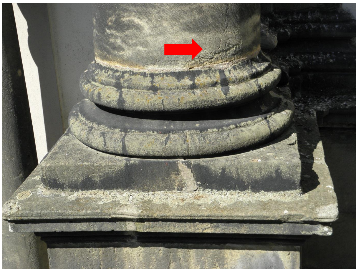
Obr. 18/ Patka sloupu vpravo. Tmavé depozity, biologický porost, eroze, hloubková koroze ■
