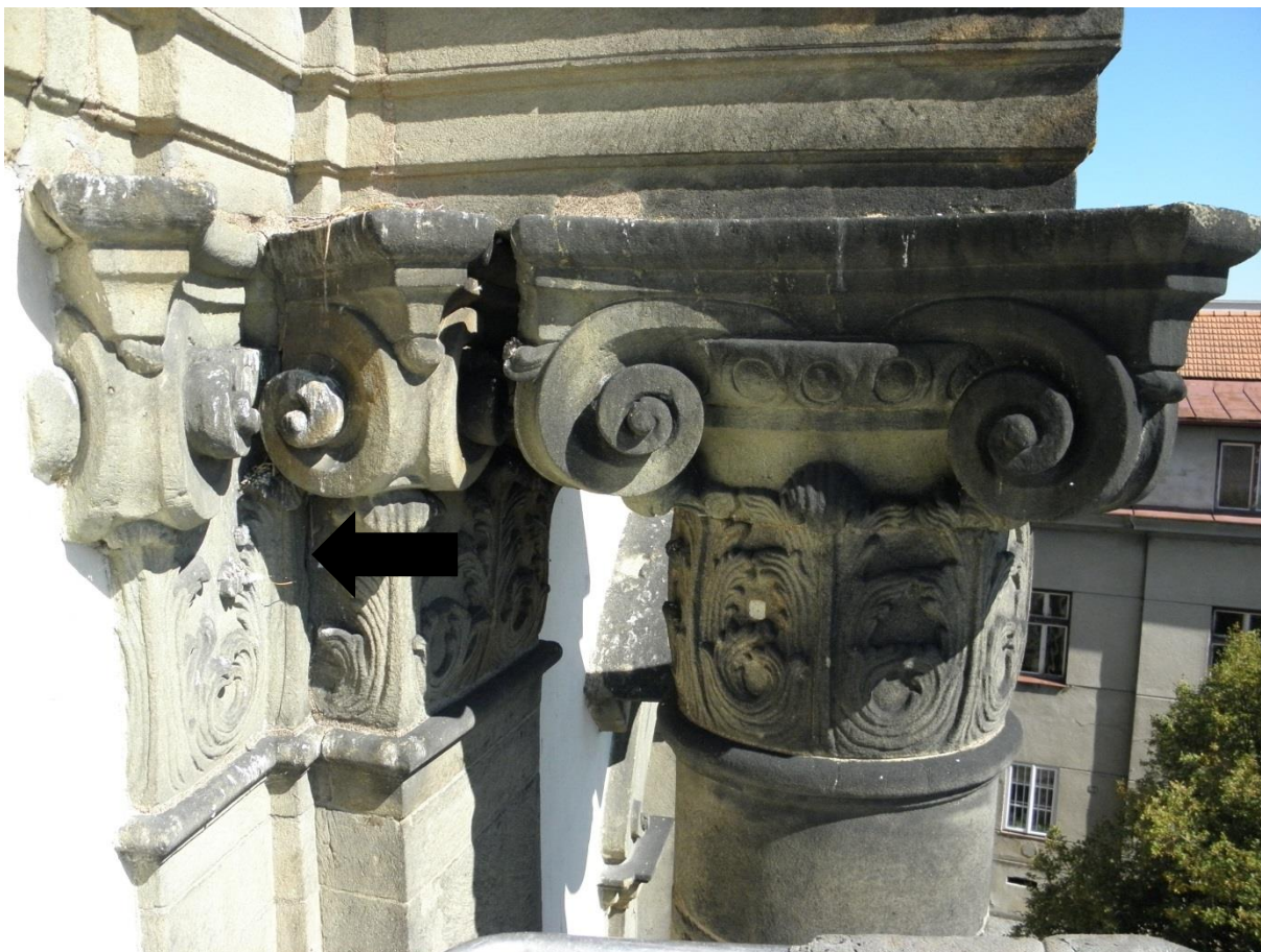
Obr. 11/ Hlavice sloupu a sruženého pilastru vlevo. Znečištěné depozity a holubím trusem, uvolněná spára ■
