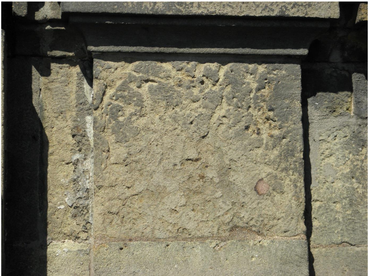
Obr. 7/ Pilastr atiky vpravo od erbu – detail. Eroze povrchu.
