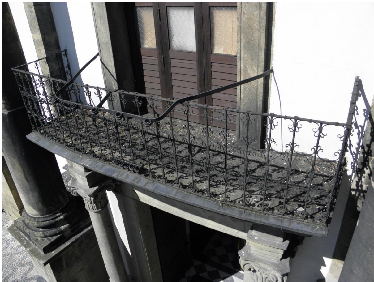
Obr. 23/ Zábradlí balkonu. Degradováno korozí.
