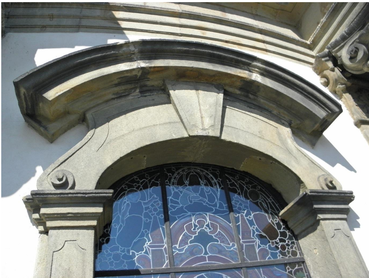
Obr. 3/ Okno průčelí – horní část. Lokálně krusty s mírnou erozí.
