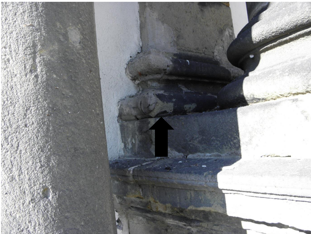
Obr. 21/ Patka pilastru za sloupem vpravo. Degradace povrchu vadnými vysprávkami ■
