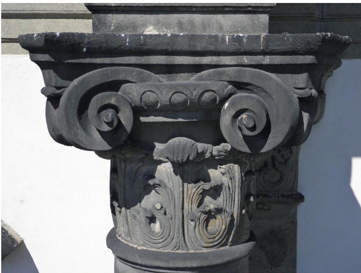
Obr. 12/ Hlavice sloupu vpravo. Znečištěná depozity a holubím trusem.
