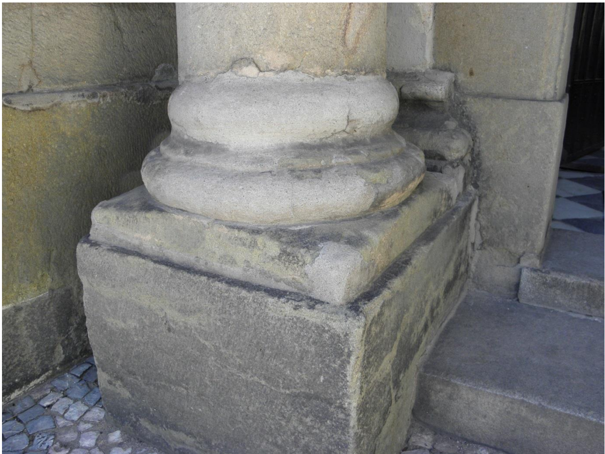
Obr. 25/ Patka sloupku portálu hlavního vchodu vlevo. Rozsáhlé neodborné opravy.
