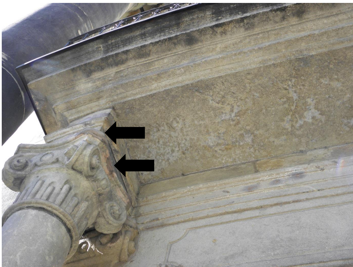
Obr. 24/ Podhled balkonu vlevo s hlavicí sloupku. Vadné vysprávkky ■
