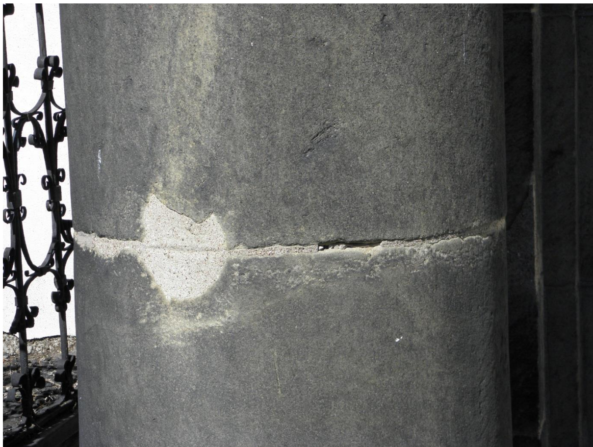
Obr. 17/ Dřík sloupu vpravo – detail. Nevhodná výplň, uvolněná spára.
