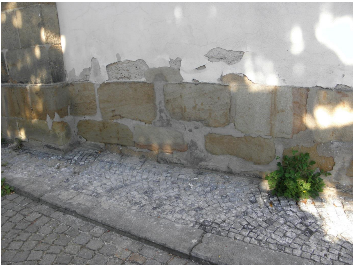
Obr. 32/ Sokl boční fasády vlevo. Vysprávky dále zhoršující stav horniny.
