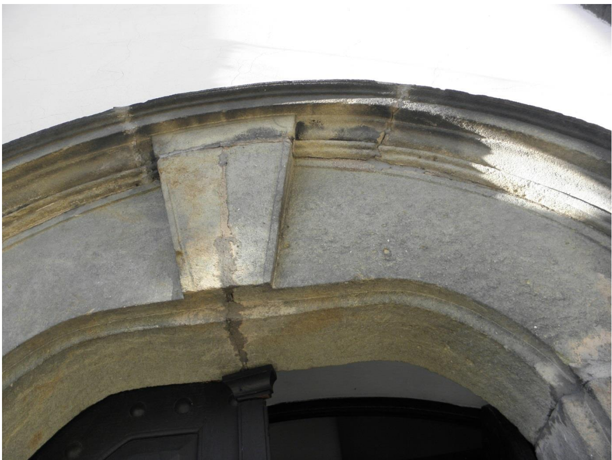
Obr. 26/ Archivolta portálu vedlejšího vchodu vpravo. Mírná eroze, uvolněné spáry
