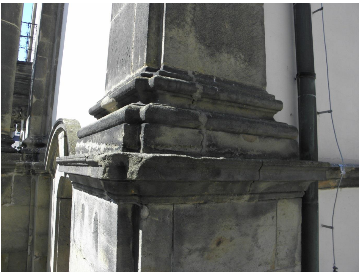
Obr. 22/ Patka sdruženého nárožního pilastru. Defekty, vadné vysprávky, uvolněné spáry.
