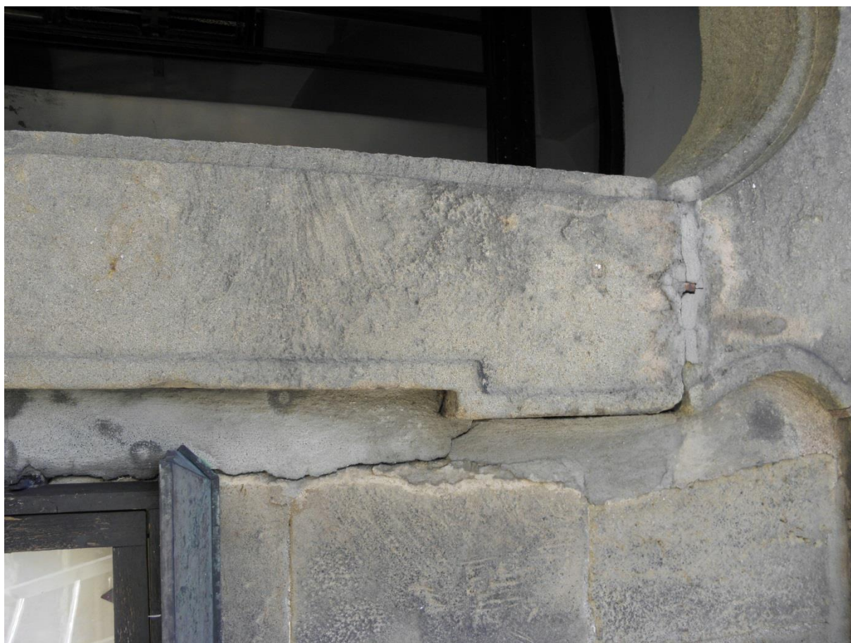
Obr. 27 a 28/ Vertikální stojka portálu vedlejšího vchodu vpravo, kus je uvolněn.
