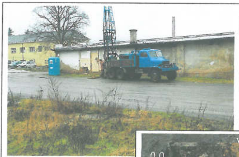
Foto 13 Vrt V-HG1 je situován zcela ve východní části areálu staveniště, za stávajícími garážemi v místech, kde je uvažováno umístění vsakovacích objektů.
