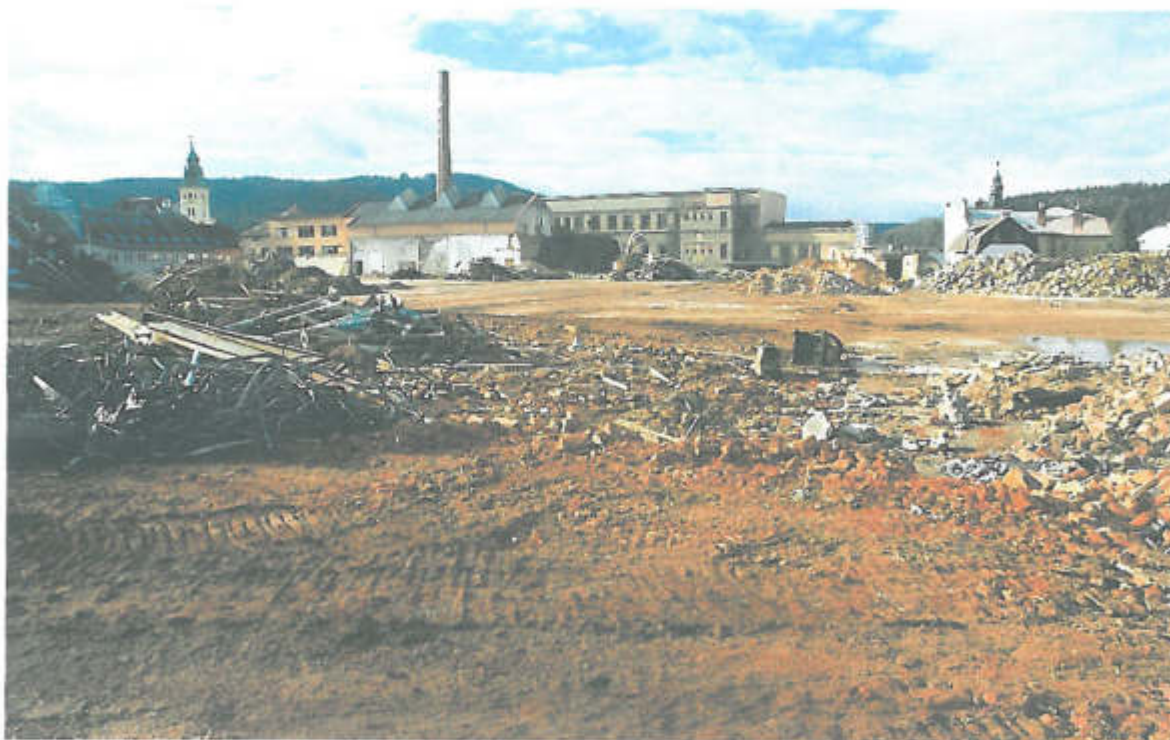
Foto 1 Celkový pohled na pozemek zvolený pro výstavbu DDM a SŠUP po asanaci původní staré zástavby textilní továrny. Terén po demolici rozlehlé výrobní haly byl v době pořízení snímku stále krytý dlažbami podlah a proto rovinný bez nerovností. Místa jsou patrné starší podzemní investice, dutiny a kolektory rozvodů. V pozadí v západním směru stojící správní budova továrny, býv. Perly 01.
