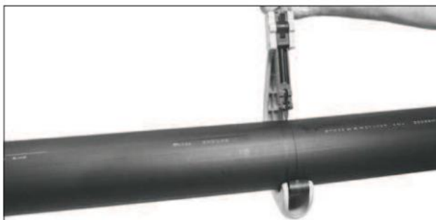
Řez potrubí ruční rotační rezačkou
