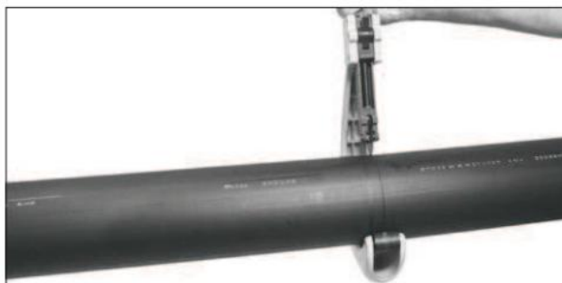
Řez potrubí ruční rotační řezačkou
