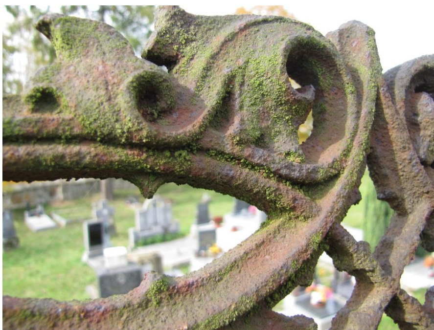
Obr. 23: Rameno kříže – biologické napadení.
