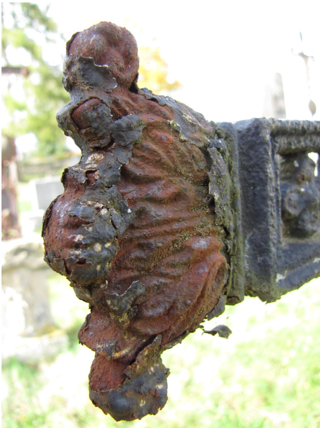
Obr. 40: Nesoudržné vrstvy povrchových úprav.
