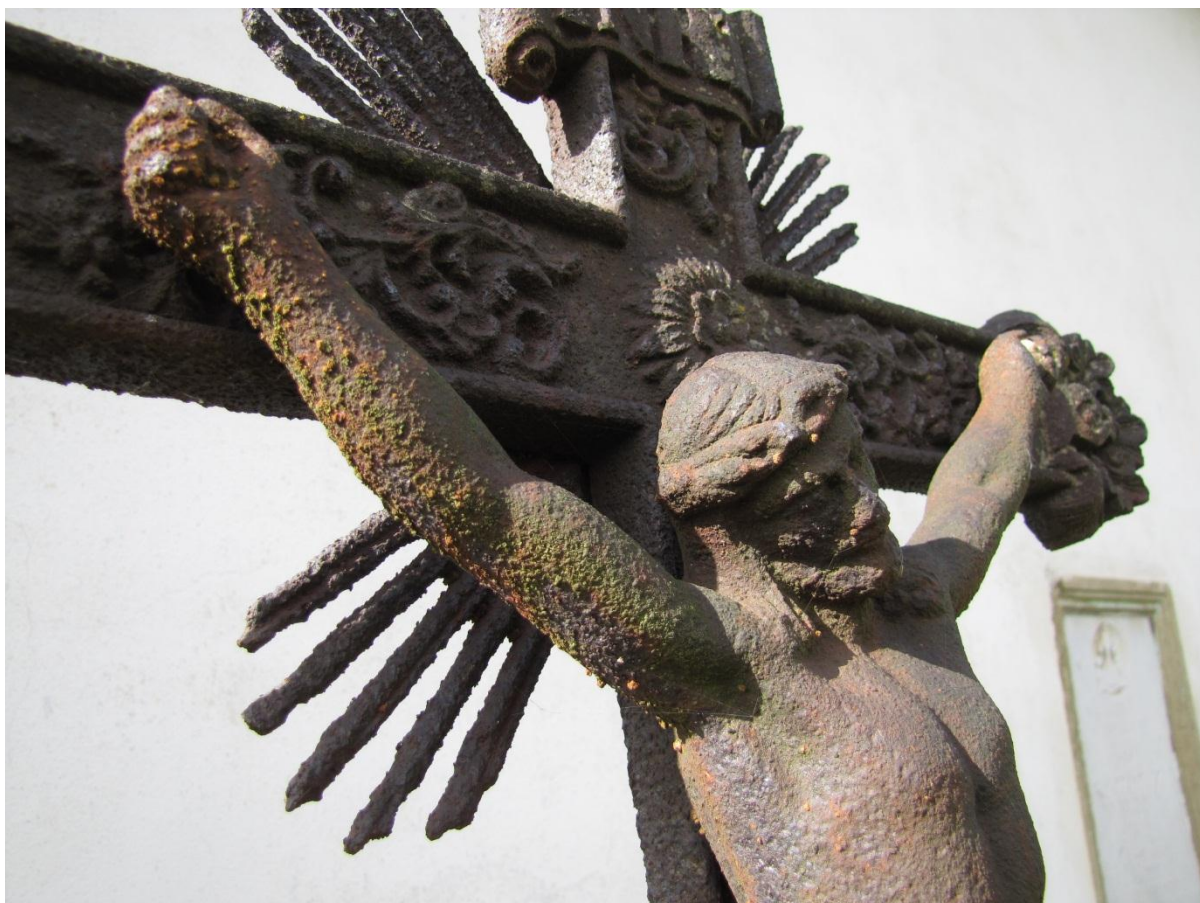
Obr. 35: Korozní a biologické napadení.
