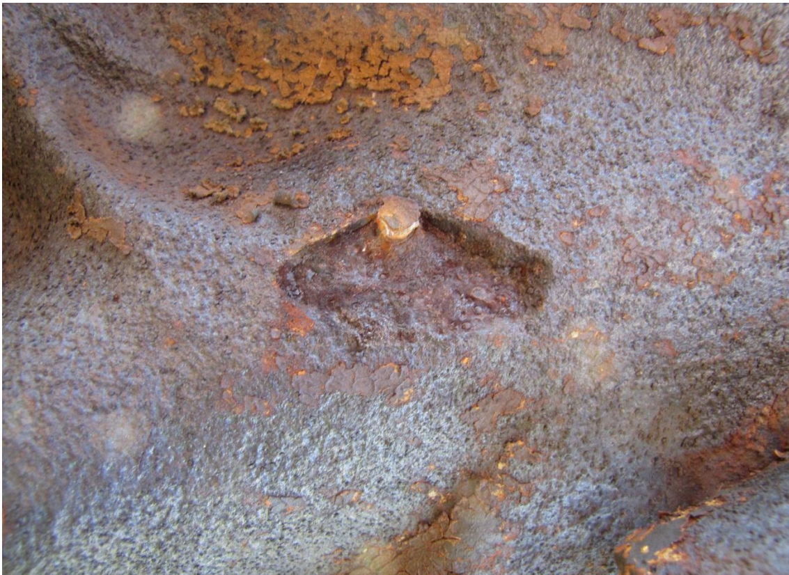
Obr. 8: Odštípnutí kusu litiny pravděpodobně v důsledku korozních tlaků v místě vyústění ocelové výztuhy z jádra.
