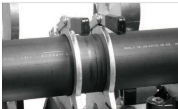
Správně připravené potrubí ke svařování
