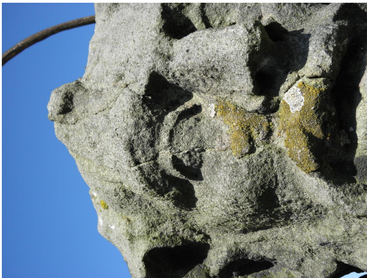
Obr. 45/ Hlava sv. Pavla. Plošně erodovaný povrch s vertikálními prasklinami ■, od nosu po konec plnovousu výplň ■, pod ní tmavé krusty □, povrch biologicky napaden
