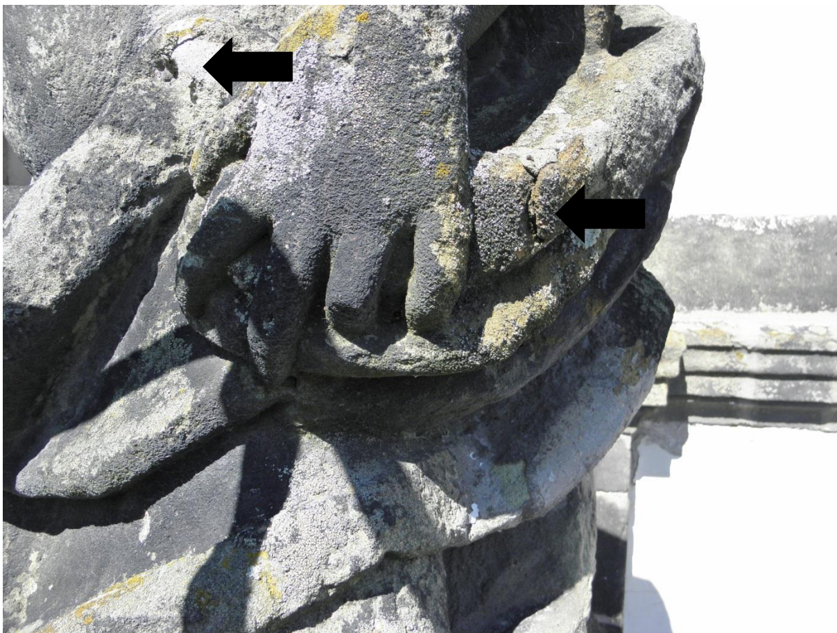
Obr. 57/ Alegorie Lásky – detail s levou rukou. Ruka pokryta výraznou vrstvou depozitů, lokálně je uchycen mechovitý porost, dochází k místní destrukci horniny ■
