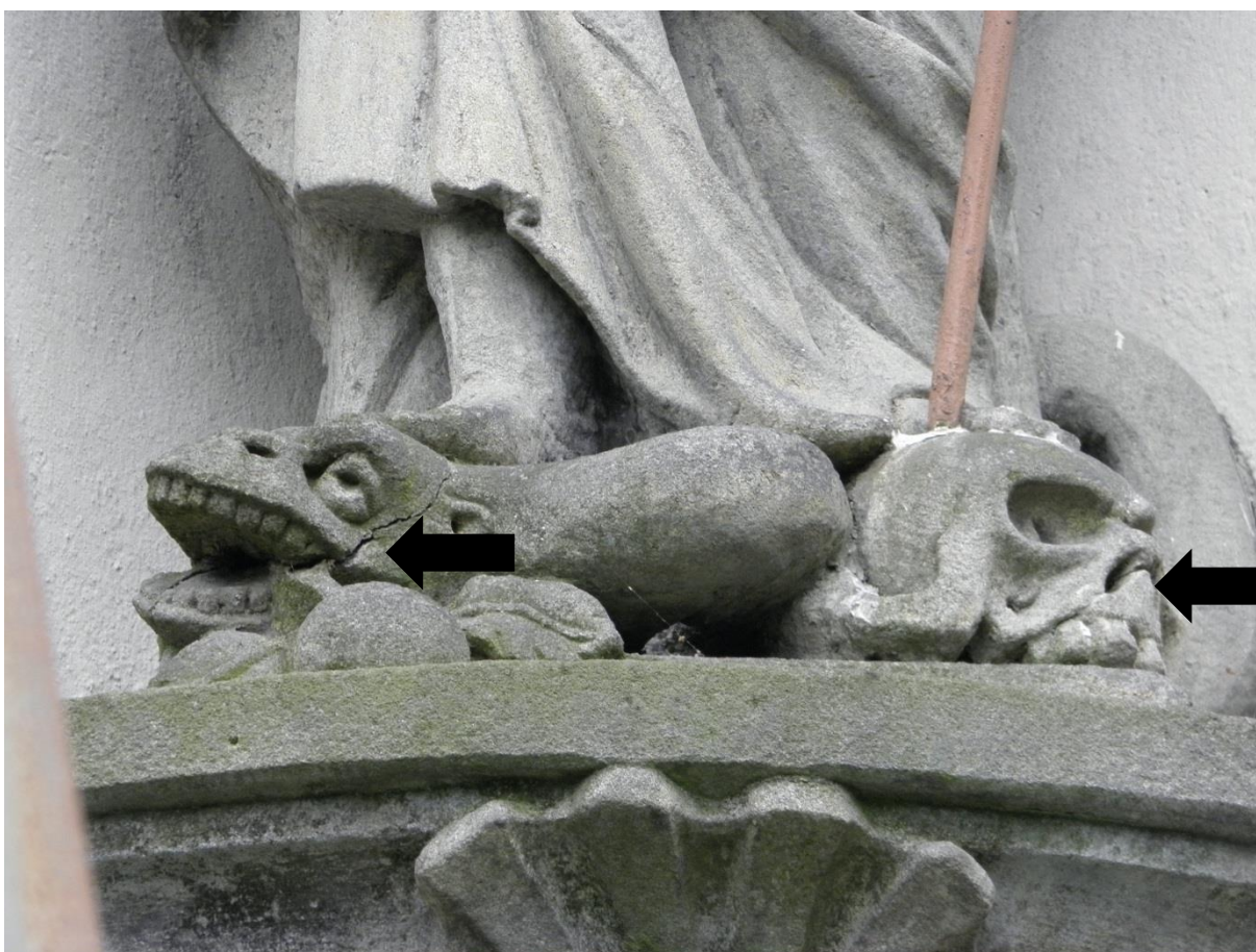
Obr. 72/ Socha Ježíše Krista. Hluboké praskliny ■, řasový porost, znečištění.
