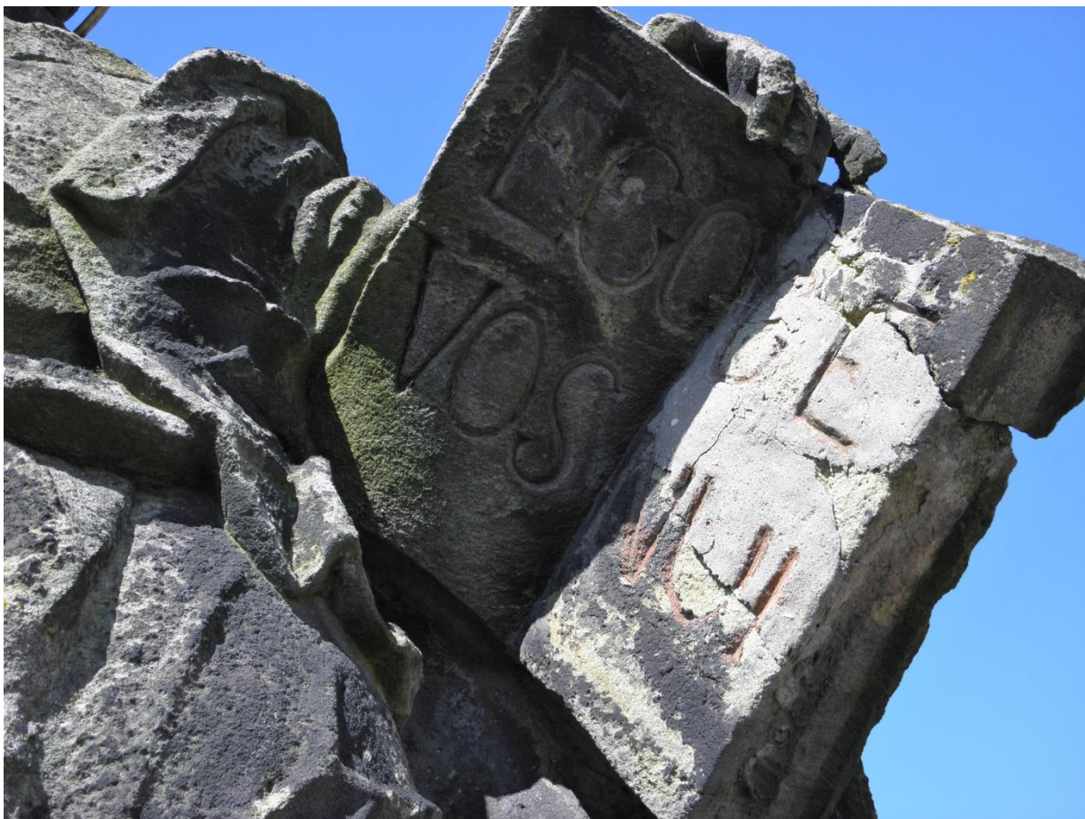
Obr. 41/ Sv. Pavel – detail. Destrukce nad cementovou výplní na knize.
