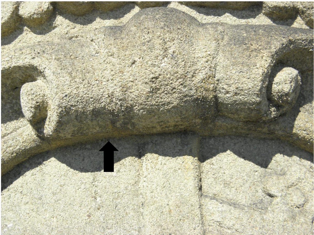
Obr. 65/ Erb, střední část – detail. Patrné zbytky polychromie ■
