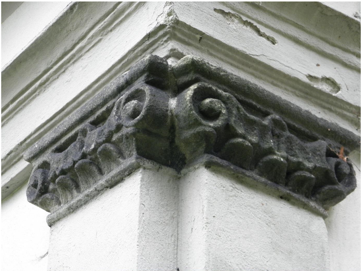
Obr. 69/ Hlavice pilastrů předsíně Útěchové kaple. Znečištěné, biologicky napadené.
