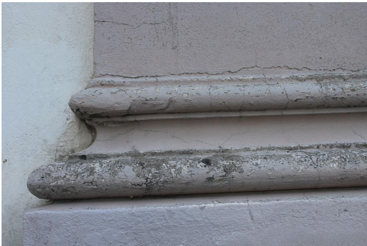
8. Loupání nátěru na plastickém článku severní strany sakristie.
