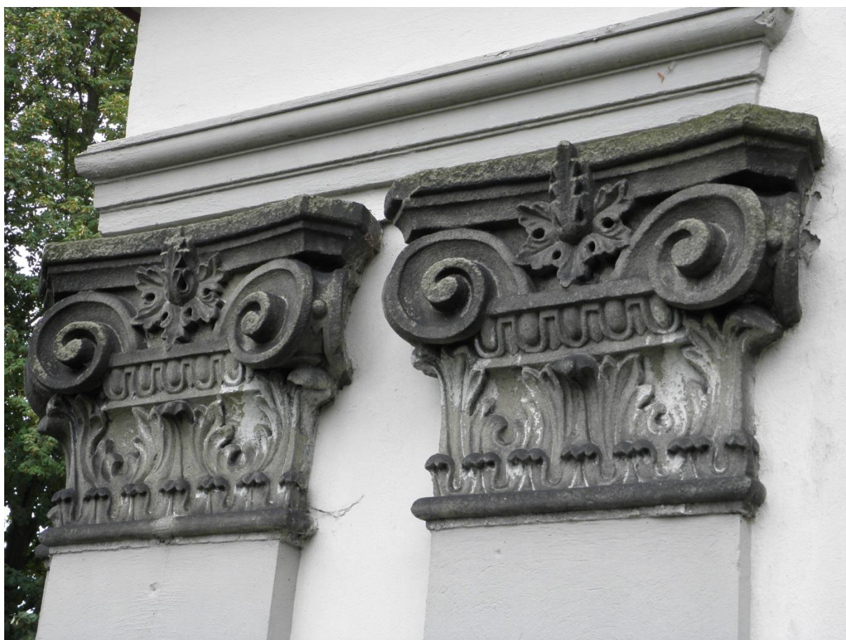
Obr. 68/ Hlavice pilastrů Útěchové kaple. Znečištěné, biologicky napadené, mírně poškozené, v dešťových stínech zbytky světlého nátěru.
