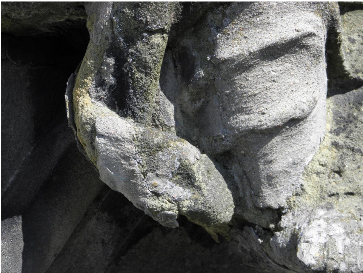
Obr. 51/ Alegorie Naděje, oblast pravé nohy - detail. Celoplošný doplněk nohy a drapérie, tmely se odlupují od podkladu, nevratná destrukce.
