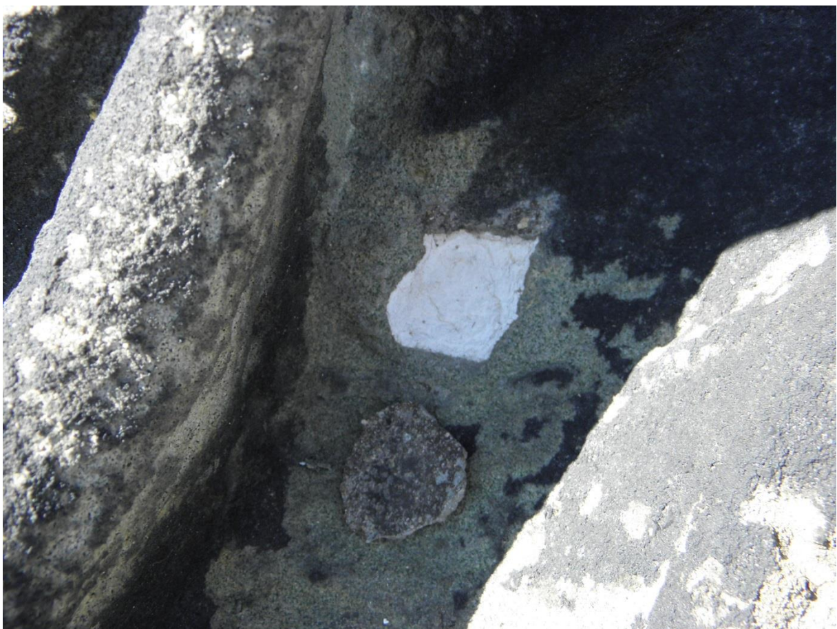
Obr. 48/ Oblast nohou sv. Pavla – vepředu. Vtokový otvor po vyjmutí cementové výplně, v otvoru je původní vápenná maltovina.
