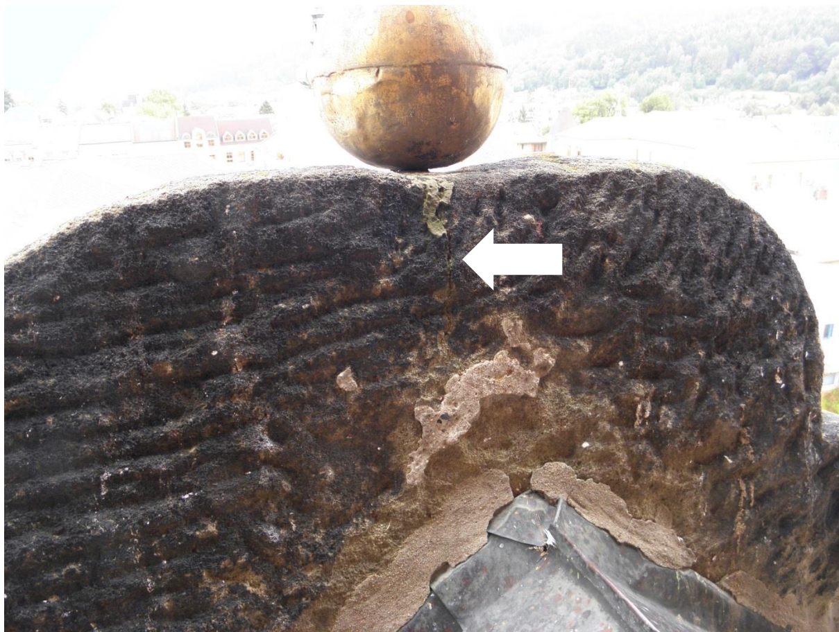
Obr. 67/ Erb, horní část zezadu – detail. Prasklina □
