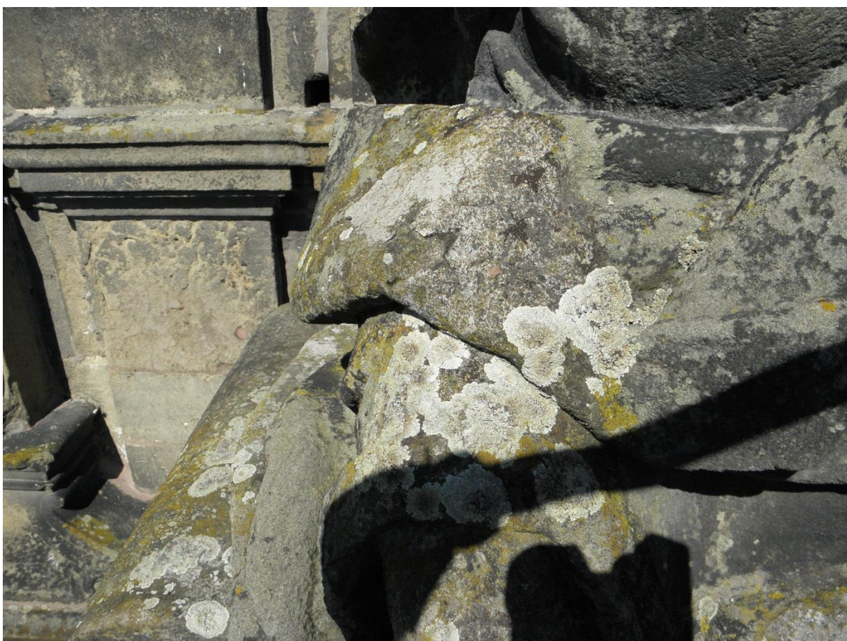
Obr. 56/ Alegorie Lásky, oblast stehén – detail. Rozšířené biologické napadení.
