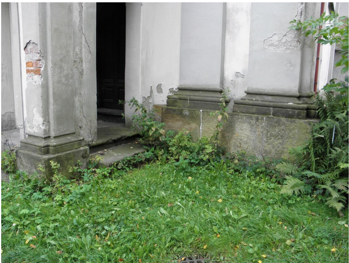
Obr. 70/ Soklové partie Útěchové kaple. Znečištěné, zavlhčené, porostlé biologickými organismy.
