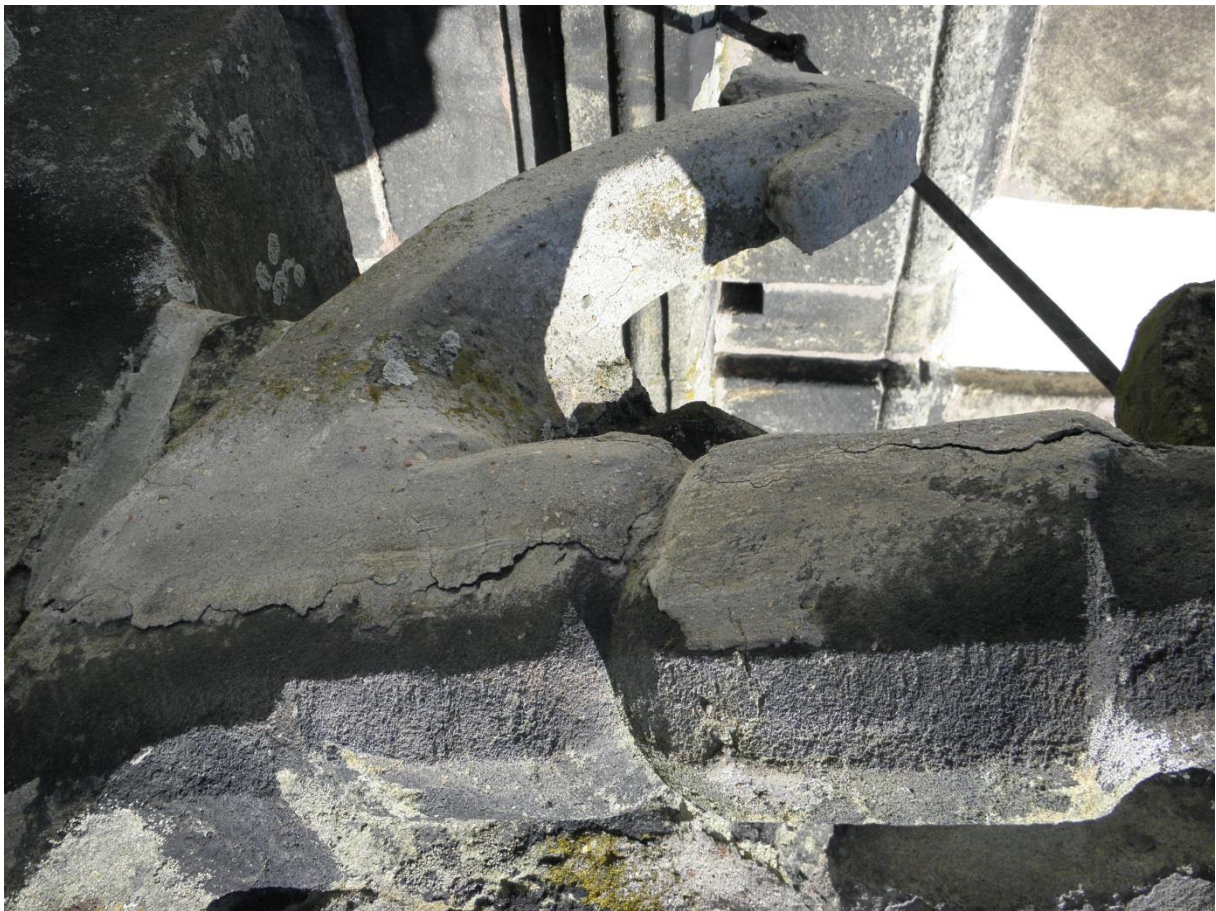
Obr. 43/ Hlava alegorie Lásky. Na povrchu se nacházejí cement. vysprávký ■ a mechovité porosty ■
