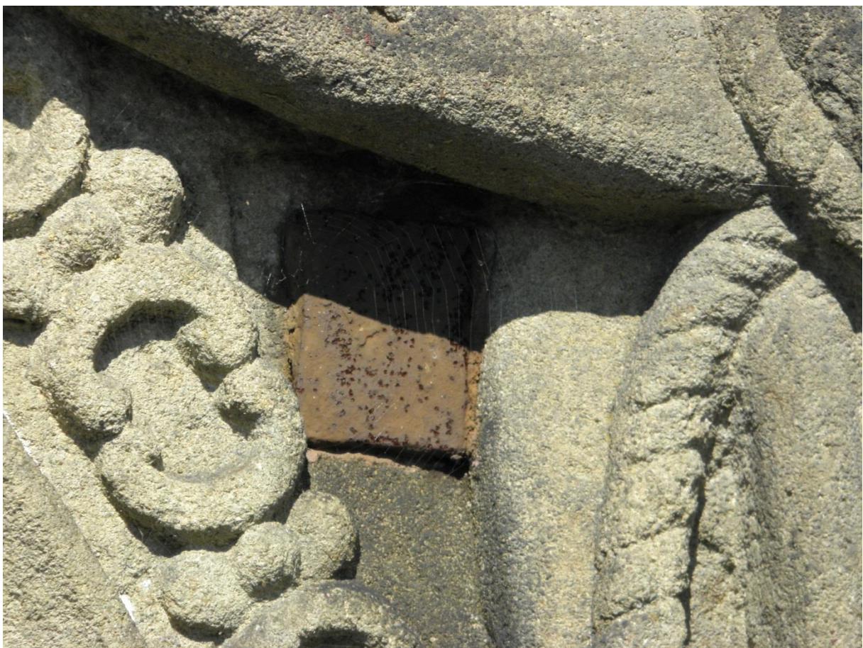
Obr. 66/ Korodující kotvící prvek erbu.
