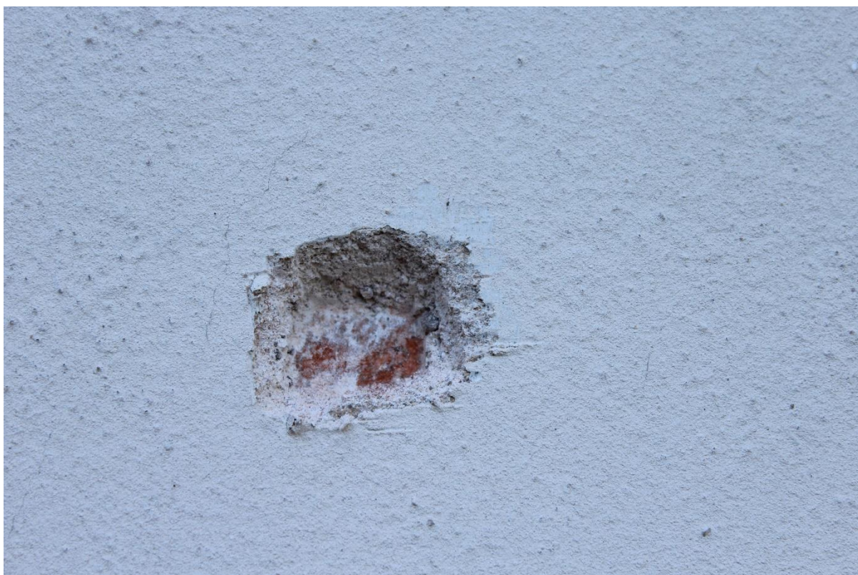
6. Ověřující sonda (S1) na západní straně sakristie – prokázala novodobé omítky.
