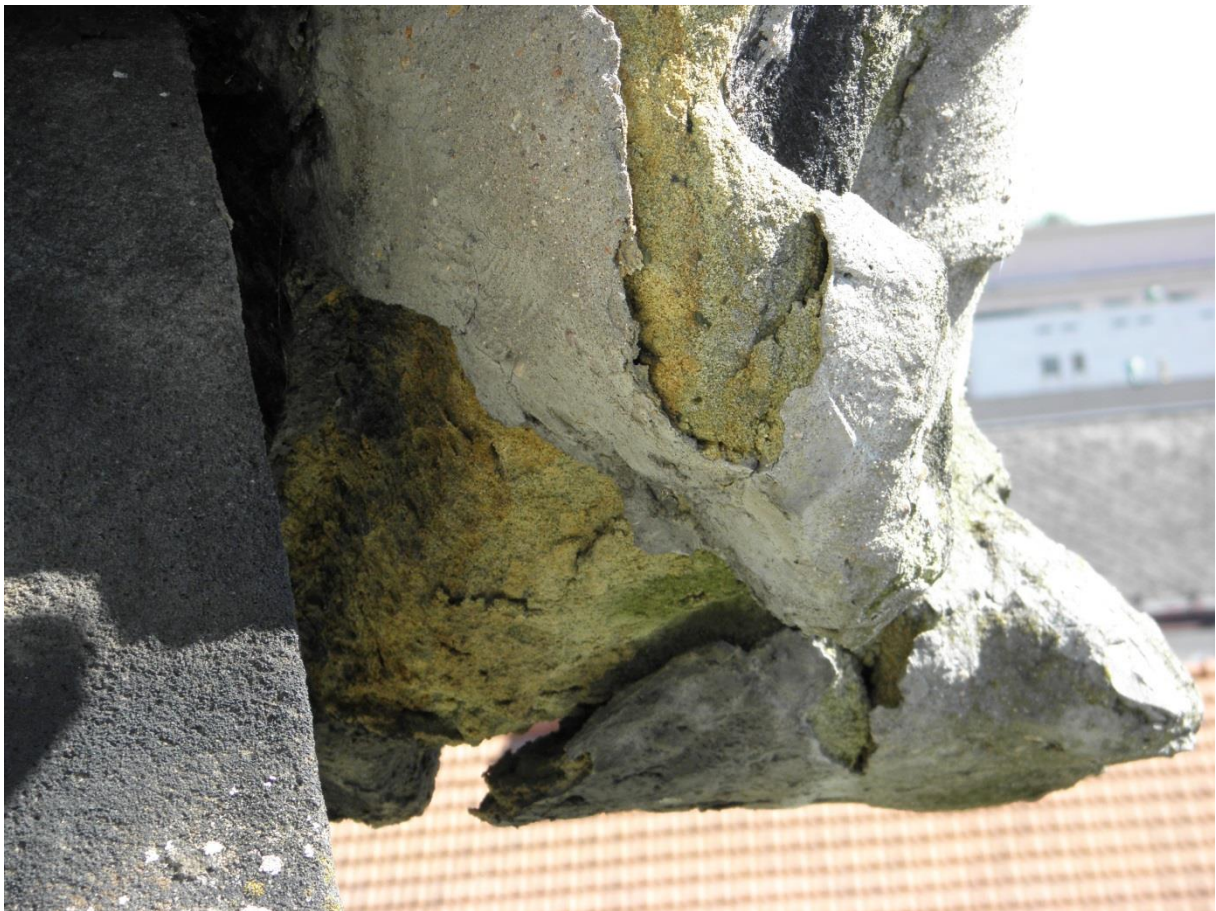
Obr. 50/ Oblast nohou alegorie Naděje - detail. Jasně patrná destrukce horniny, výrazná eroze, odpadávající cementové nánosy, hrozí upadnutí většího kusu nohou
