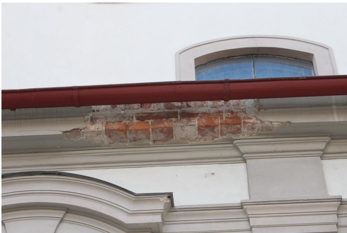
5. Chybějící část římsy na západní straně sakristie.
