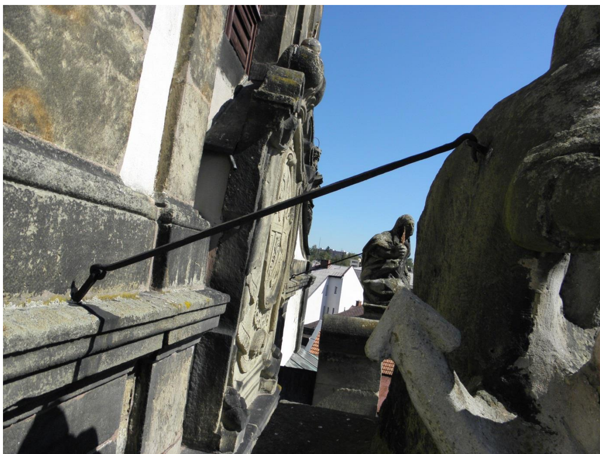
Obr. 62/ Allegorie Naděje. Způsob ukotvení do fasády kostela.
