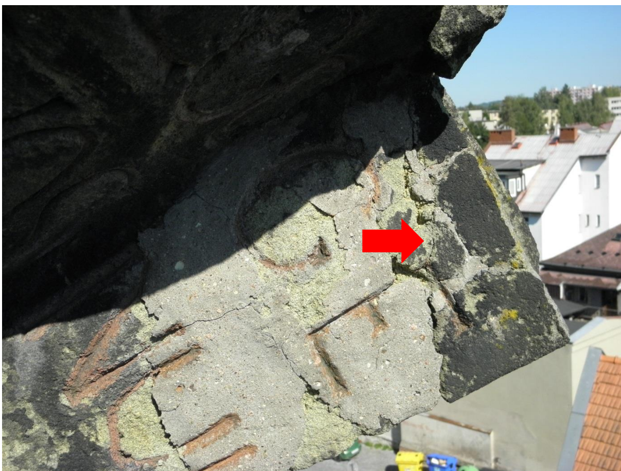
Obr. 42/ Detail knihy u sv. Pavla. Plocha s nápisem v minulosti rekonstruována, část za prasklinou ■ hrozí odpadnout.
