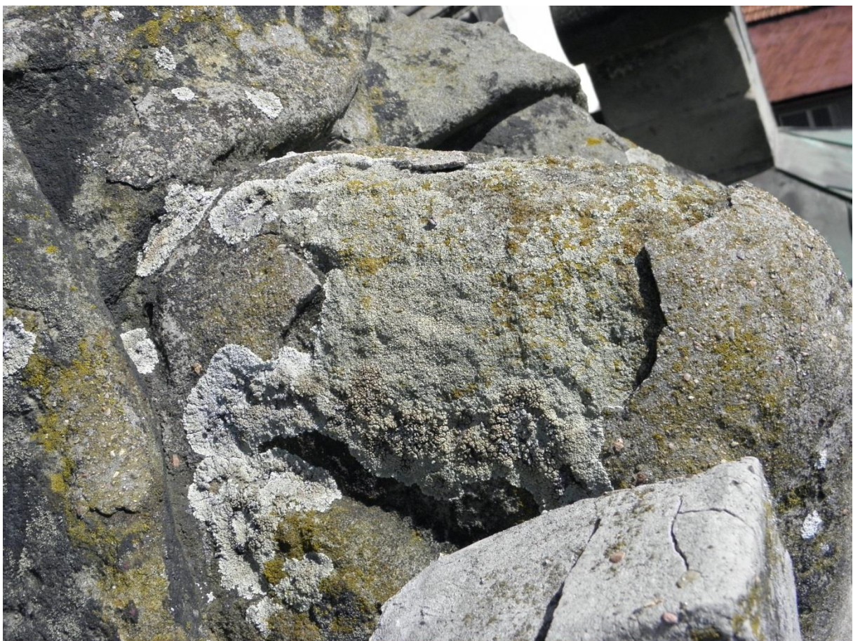
Obr. 52/ Alegorie Naděje, stehno pravé nohy – detail. Hornina po odpadnutí cementového doplňku hustě porostlá lišejníkovitými porosty.
