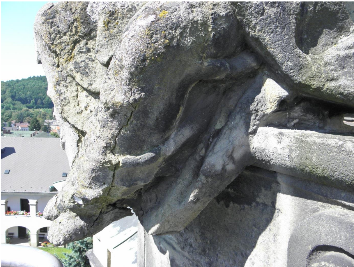
Obr. 49/ Oblast nohou alegorie Naděje. Jasně patrná destrukce horniny, výrazná eroze, biologické porosty, vespod tmavé sádrovcové krusty
