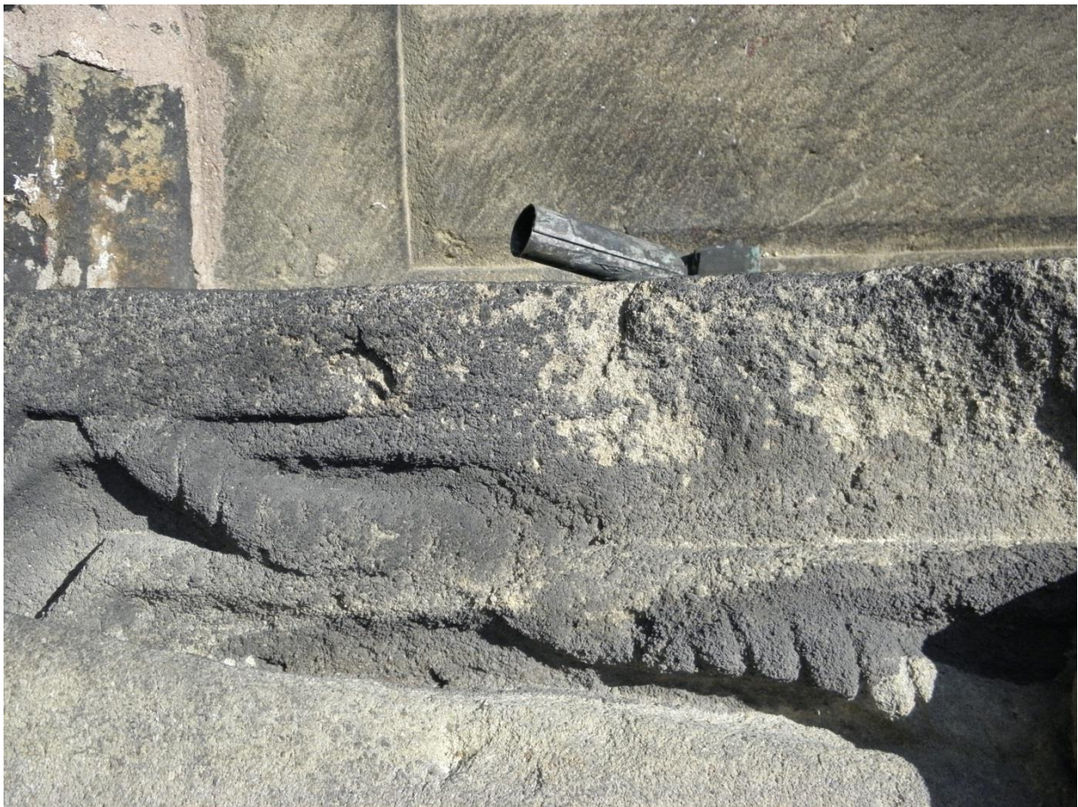
Obr. 63/ Horní část erbu zprava. Eroze exponovaných ploch a především silné biologické napadení povrchu.
