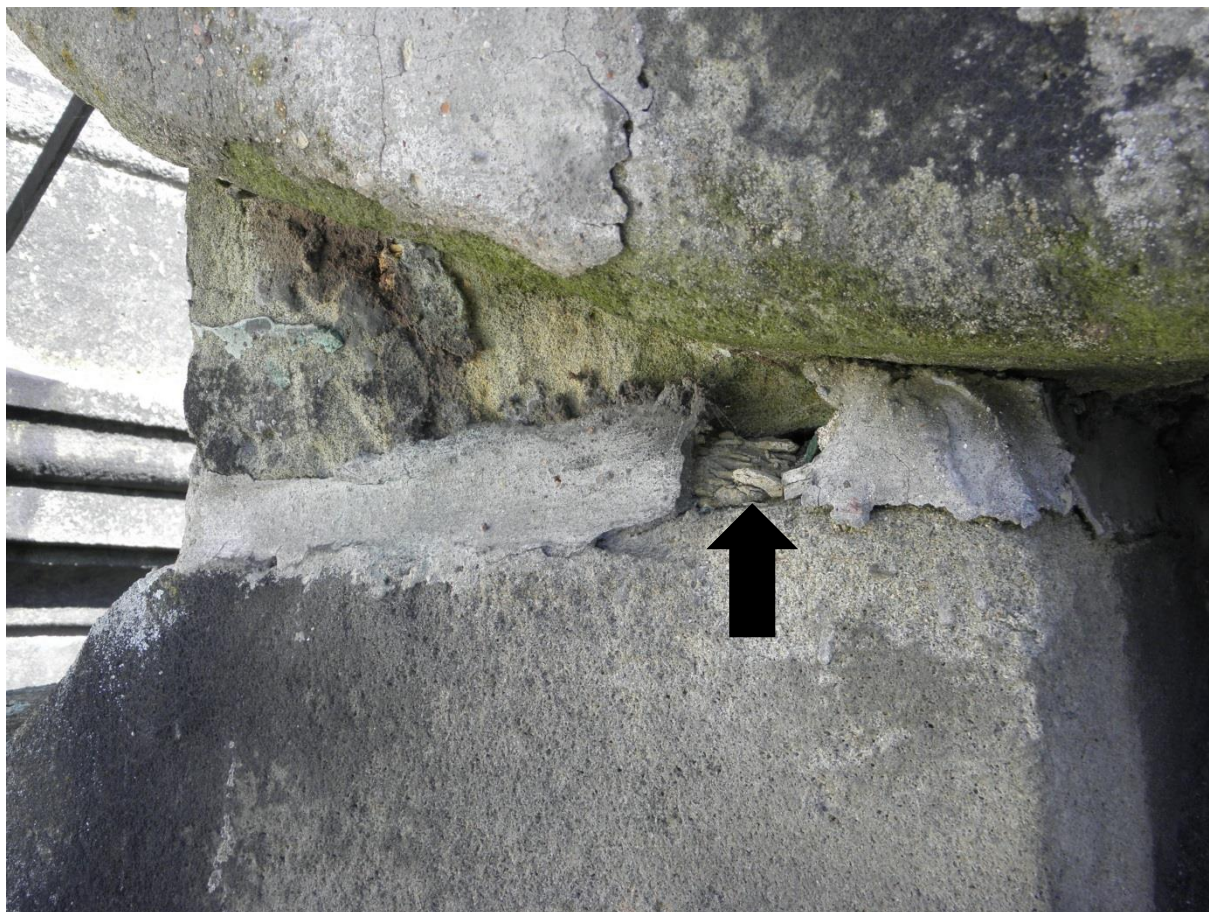
Obr. 53/ Allegorie Naděje, spára pod sochou. V místě vypadlé cementové výplně je vidět původní spárovou maltovinu ■
