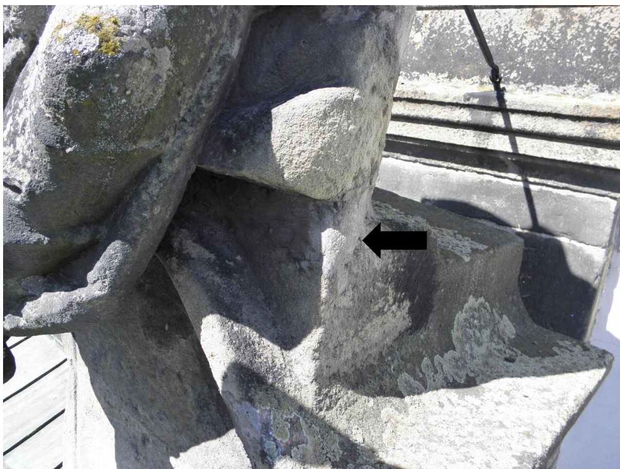
Obr. 54/ Allegorie Lásky – pohled zprava. Cementová výplň spáry pod sochou ■
