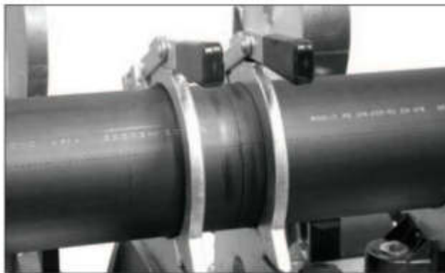
Správně připravené potrubí ke svařování
