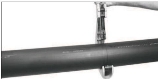
Řez potrubí ruční rotační řezačkou
