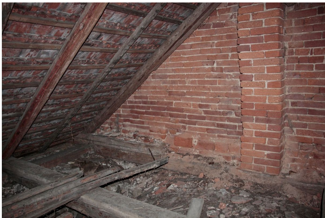
30. Zdivo západního štítu ze strany půdního prostoru.
