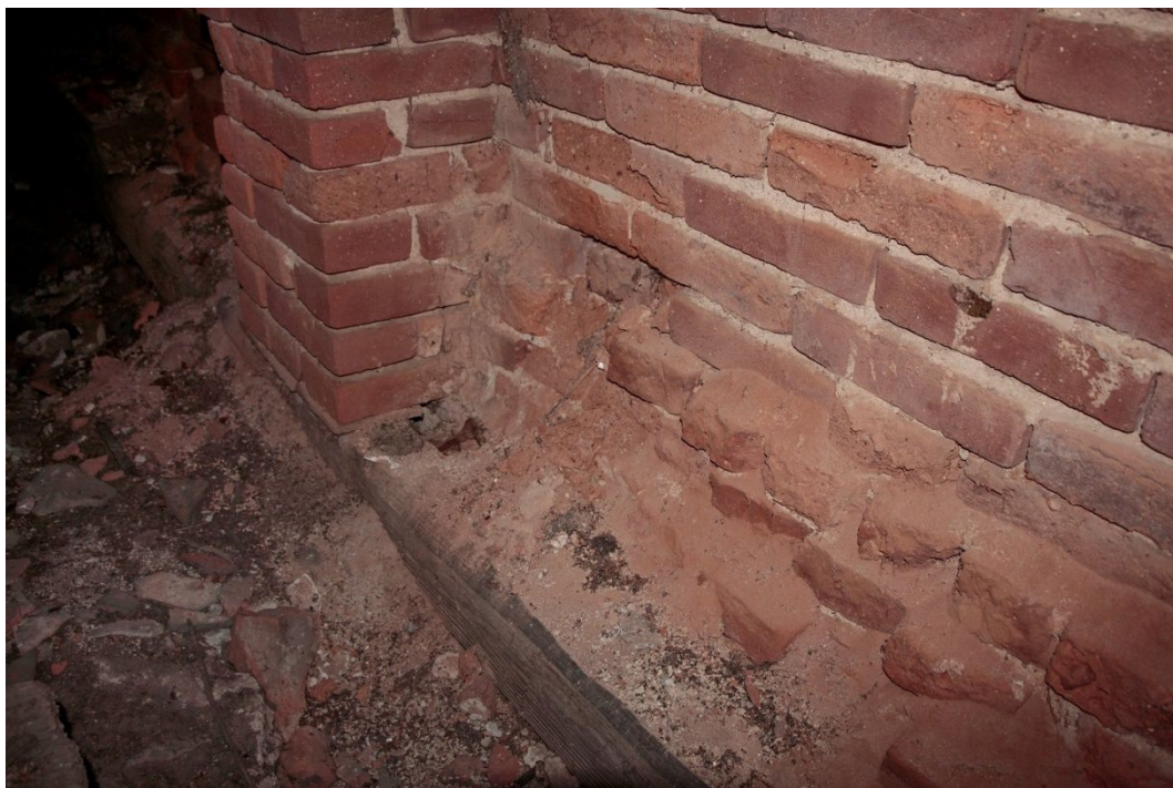
31. Vazný trám krajní vazby, na němž je vyzděný ztužující cihelný pilířek západního štítu. Velmi měkce pálené cihly štítového zdiva jsou do hloubky degradované.
