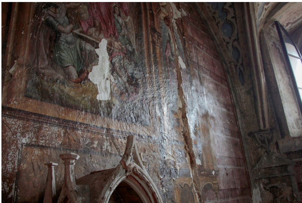
15. Masivní kondenzace vzdušné vlhkosti na povrchu vnitřních omítek
