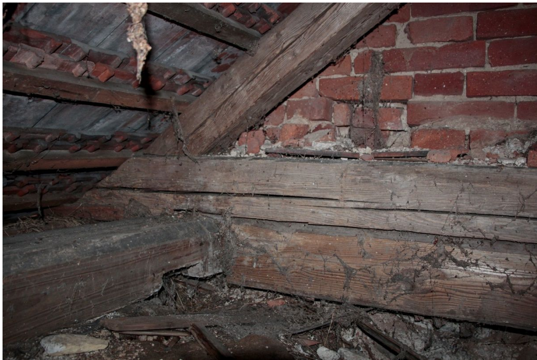
33. Detail krajní vazby u západního štítu s dodatečnou výměnou vazného trámu.
