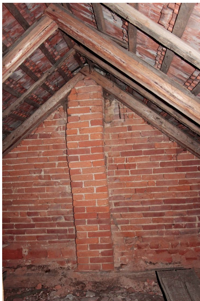
17. Do hloubky rozpadlé velmi měkce pálené cihly západního štítu
