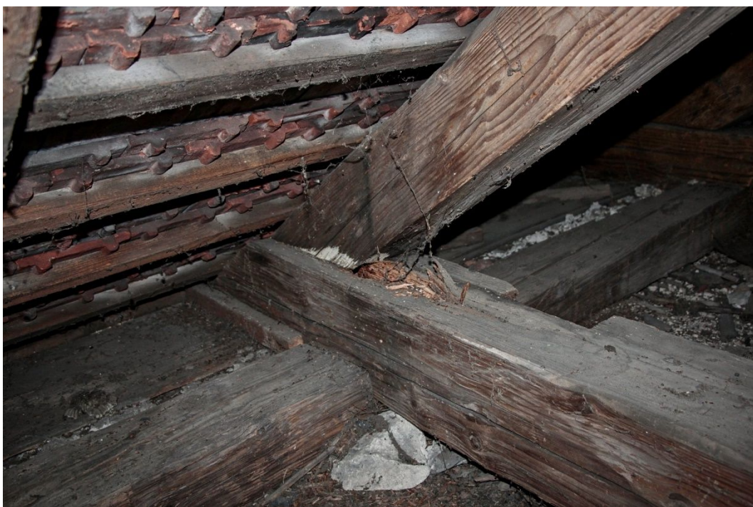
36. Kráče a konec krokve, značně poškozené kornatcem.
