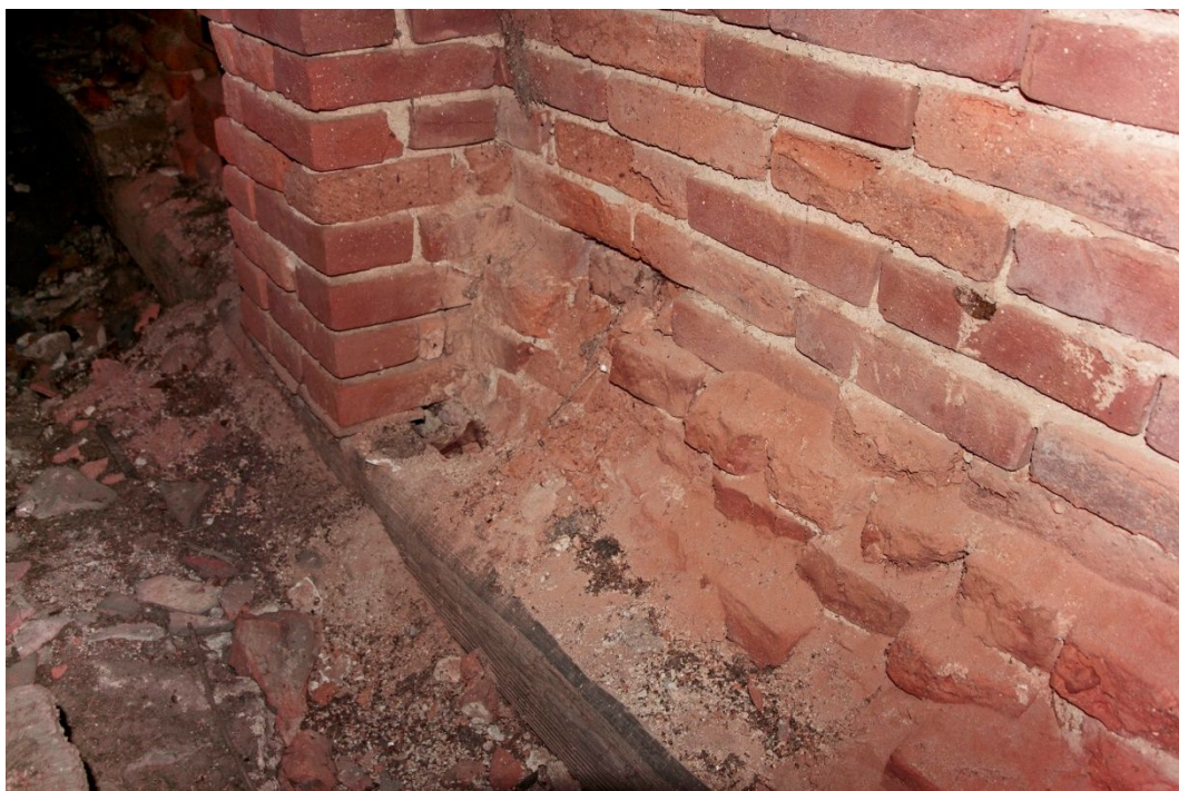
17. Do hloubky rozpadlé velmi měkce pálené cihly západního štítu
