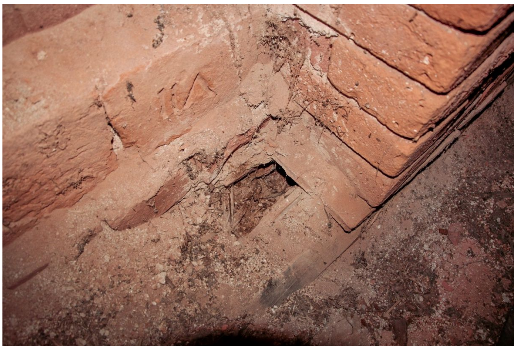
32. Zcela destruovaný vazný trám krajní vazby v místě průchodu zdíkem ztužujícího pilířku štítu.
