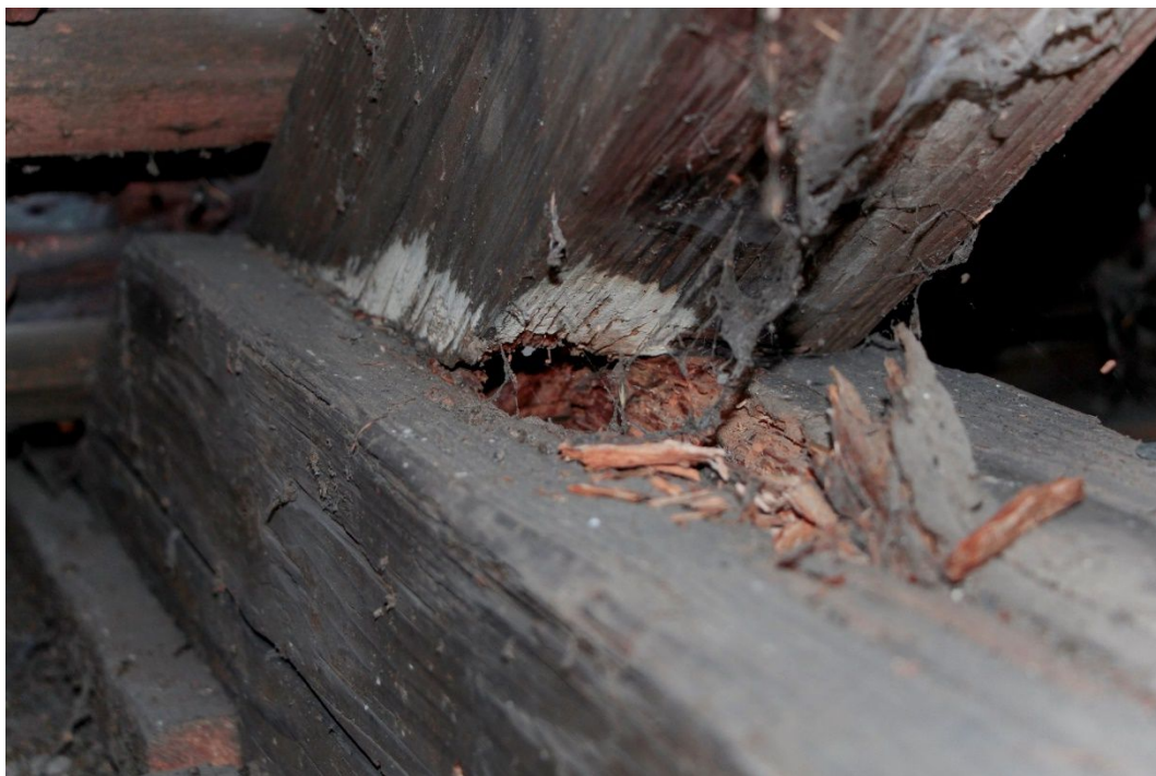
19. Příklad poškození styku krokve a vazného trámu dřevokaznou houbou
