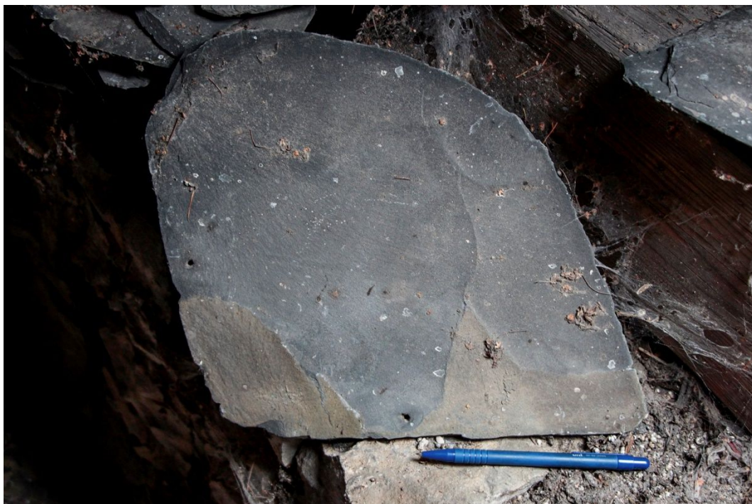
20. Nález starších břidlicových kamenů typu německá šupina v půdním prostoru
