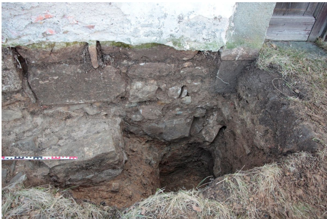
28. Část sondy provedená pod základovou spáru dodatečné zazdívky prostoru triumfálního oblouku
