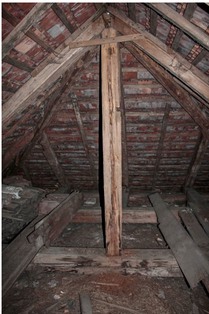
35. Středový sloupek, podpírající nárožní krokve valby, silně po- škozený trávou a červotočem.
