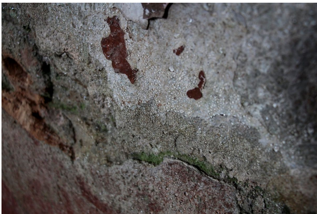
16. Detail masivní kondenzace na povrchu vnitřních omítek
