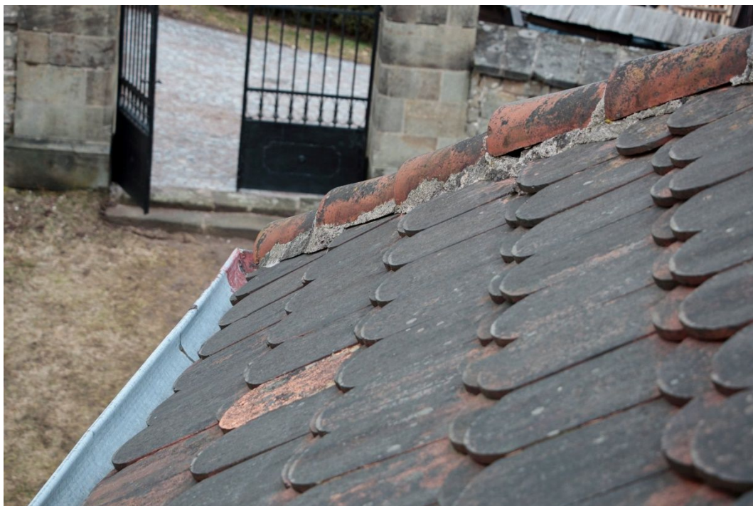
29. Technický stav stávající krytiny z keramických tašek bobrovek
