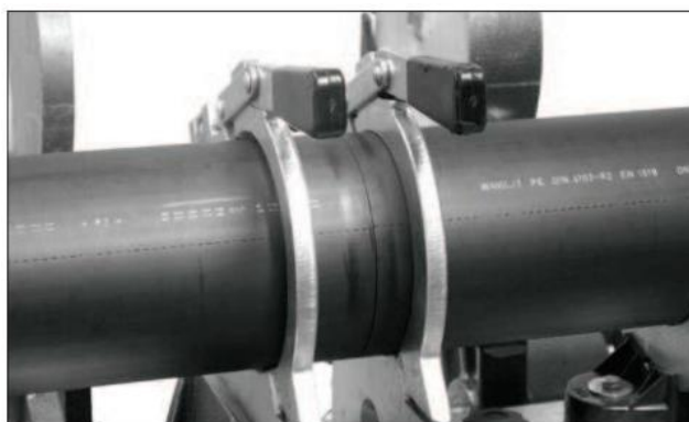
Správně připravené potrubí ke svařování
